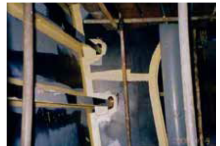
素地に Interbond® 808 (アルミニウム) 塗装及び、エッジ部分にストライプ塗装
