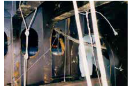
塗装前のバラストタンクの状態
