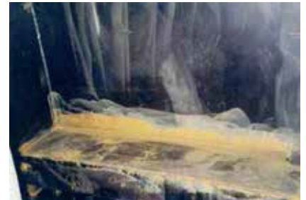
高圧洗浄機による、ハイロッドブラスト処理及び錆除去
