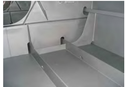
新造船时施工用于压载水舱
