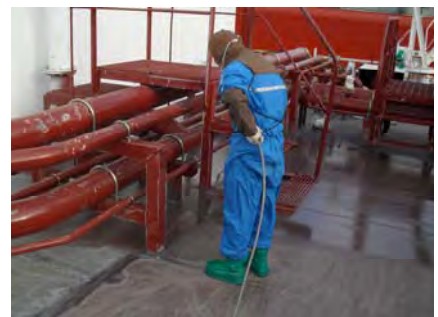
施工用于露天甲板
