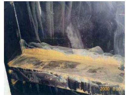
水力喷砂，清除腐蚀，随后进行高压淡水冲洗
