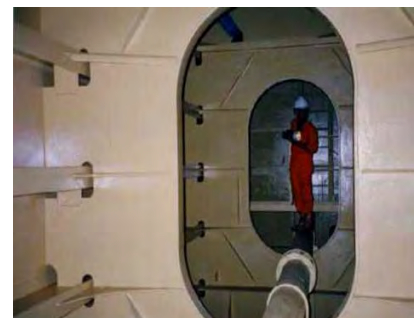
完成Interbond®808施工
