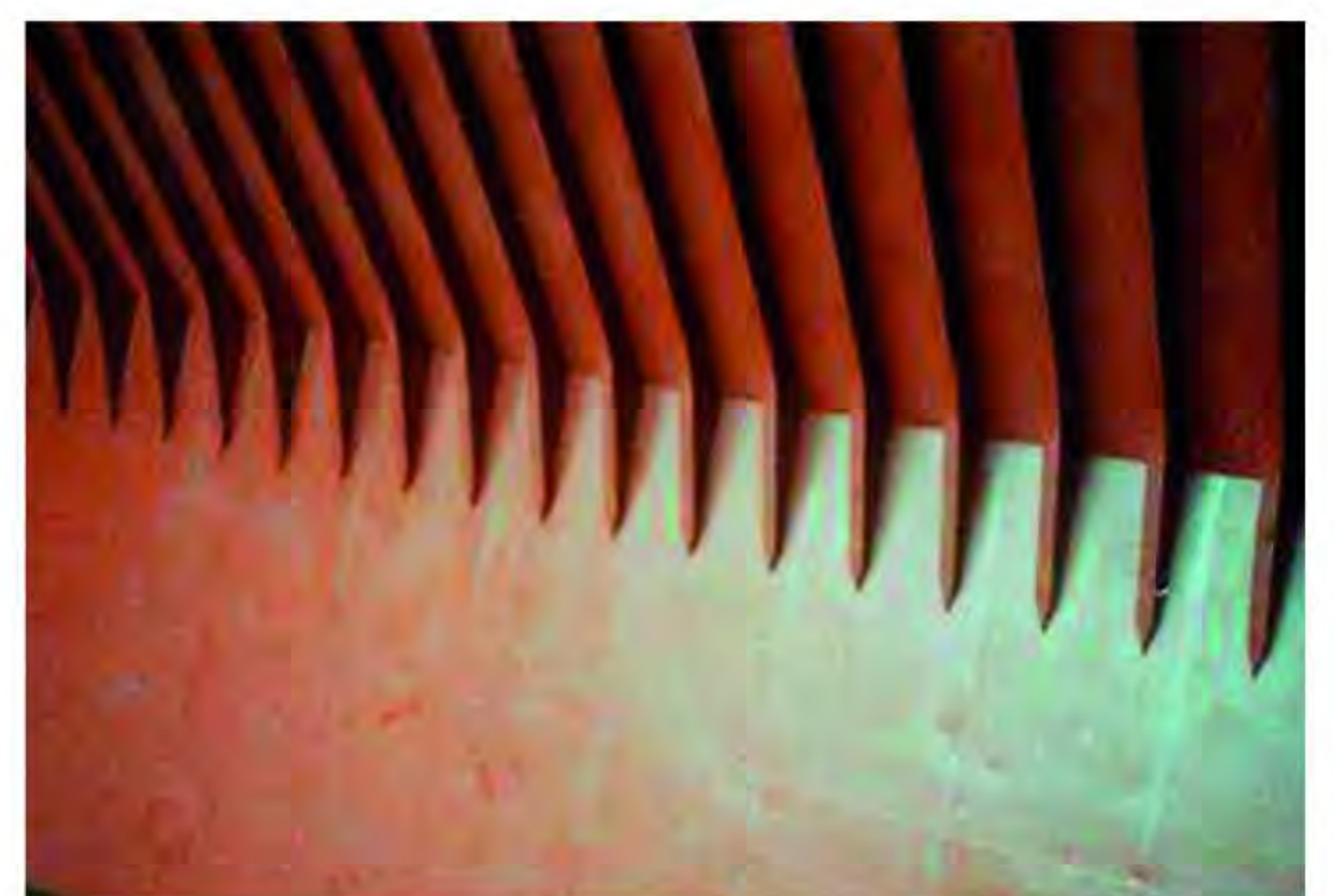
平滑、光洁的表面利于货物脱离和清理
