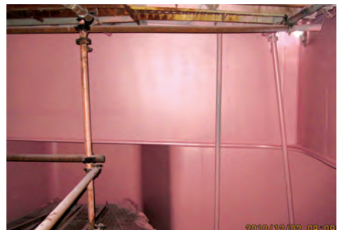
刚刚施工完成
