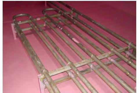
刚刚施工完成
