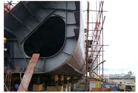
外部船体和压载舱区域施工完成
