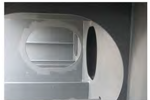
压载舱分段施工完成
