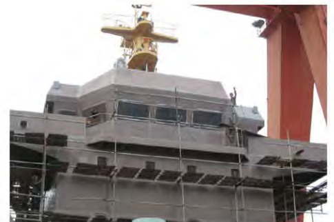
施工用于上层建筑 - 在新造船阶段用作通用底漆
