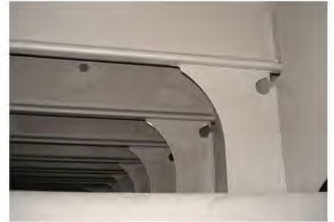
新造船压载舱上优异的施工性能和最终的外观状态
