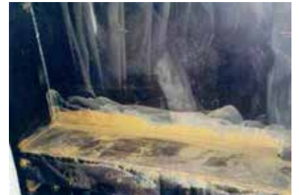
高圧洗浄機による、ハイロッドブラスト処理及び錆除去
