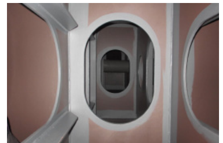
分段阶段压载舱第一度油漆和预涂
