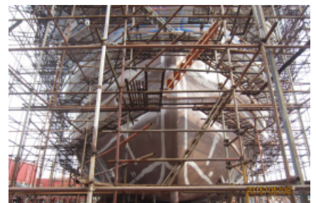
外部船体油漆施工完毕
