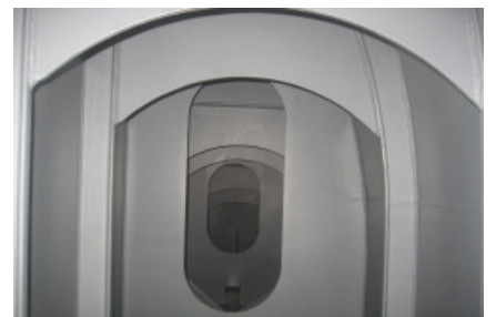
压载舱的施工完成状况
