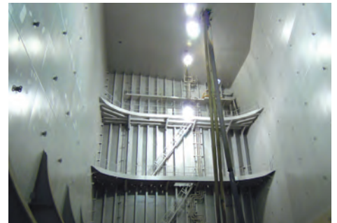
在复杂构件上有良好的施工性能
