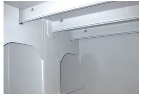
刚刚施工完成
