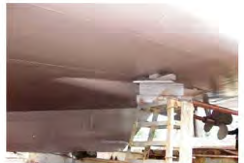
施工用于巡逻船的水下船体
