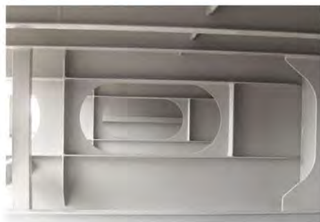
分段阶段-优异的施工性能和最终的漆膜外观
