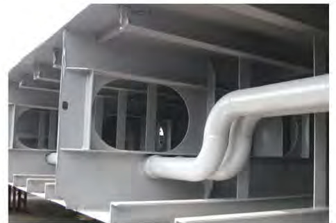
压载舱分段施工完成
