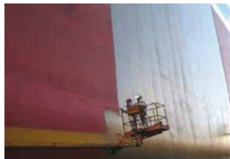
施工Intersleek®7180 Linkcoat
