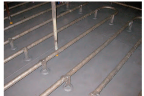
Interline®994刚刚施工完成
