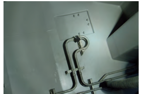
Interline®994刚刚施工完成
