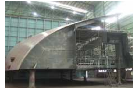
El Intergard®7500 aplicado en tanque de agua de lastre
