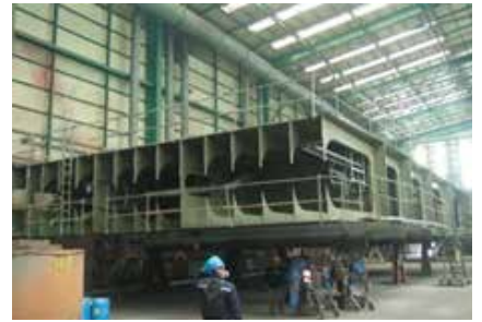
Intergard®7500 施工用于隔离舱
